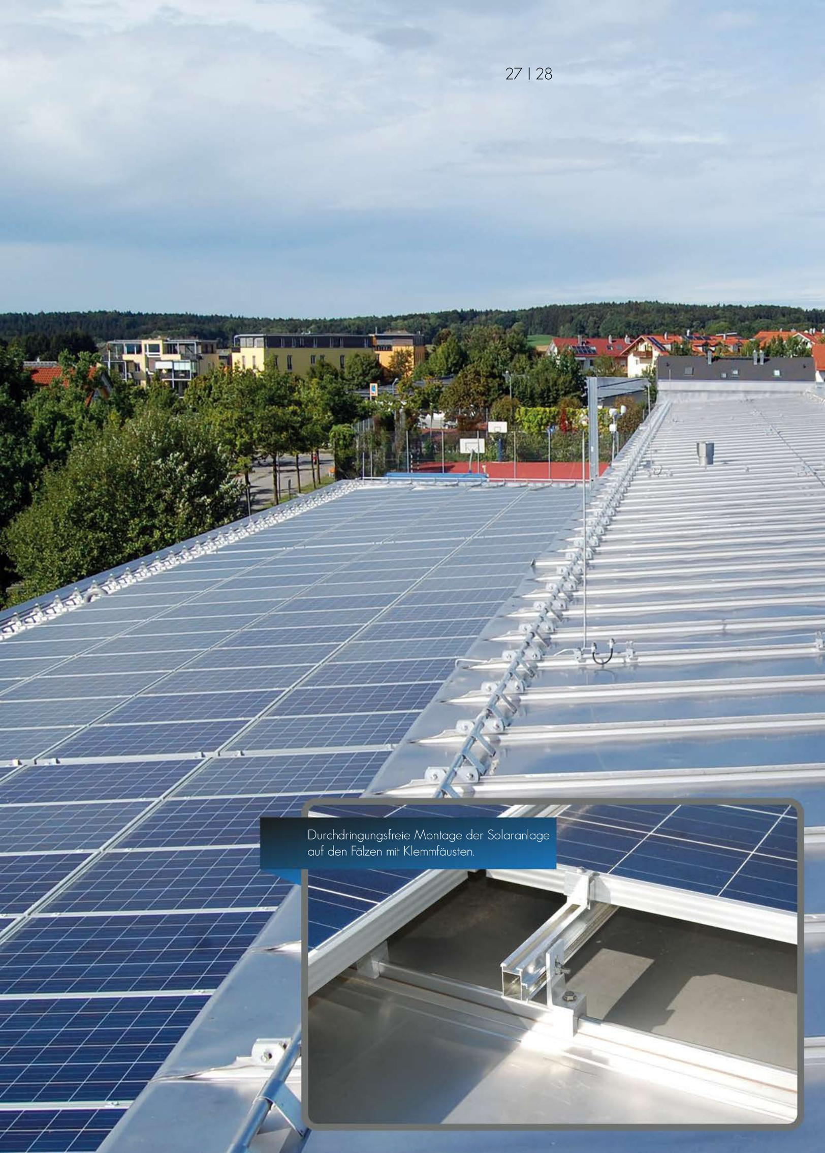
Durchdringungsfreie Montage der Solaranlage auf den Fälzen mit Klemmfäusten.
